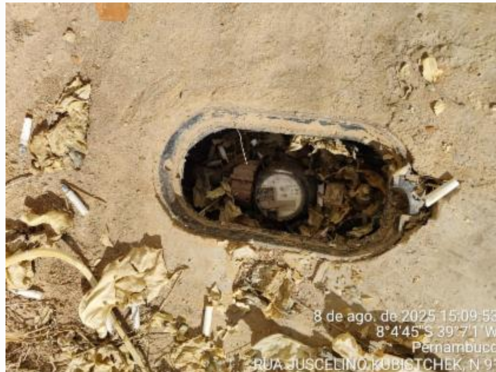
Hidrômetro Compesa - ligação cortada
