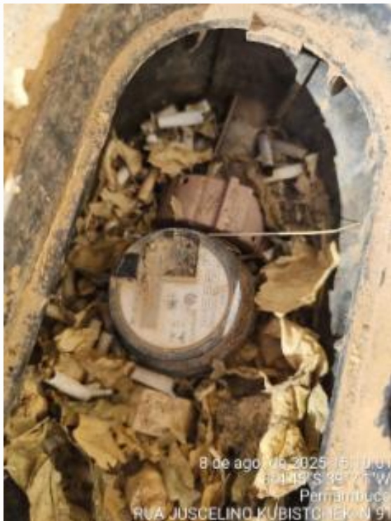
Hidrômetro Compesa - ligação cortada
